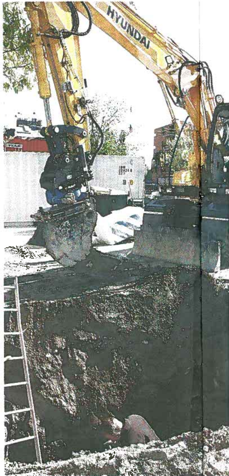
Gropman. Har man jobbat nere i gropen har man förutsättningar att bli en bra kompetent personal i branschen är svårt och för Addschakt är personalen
